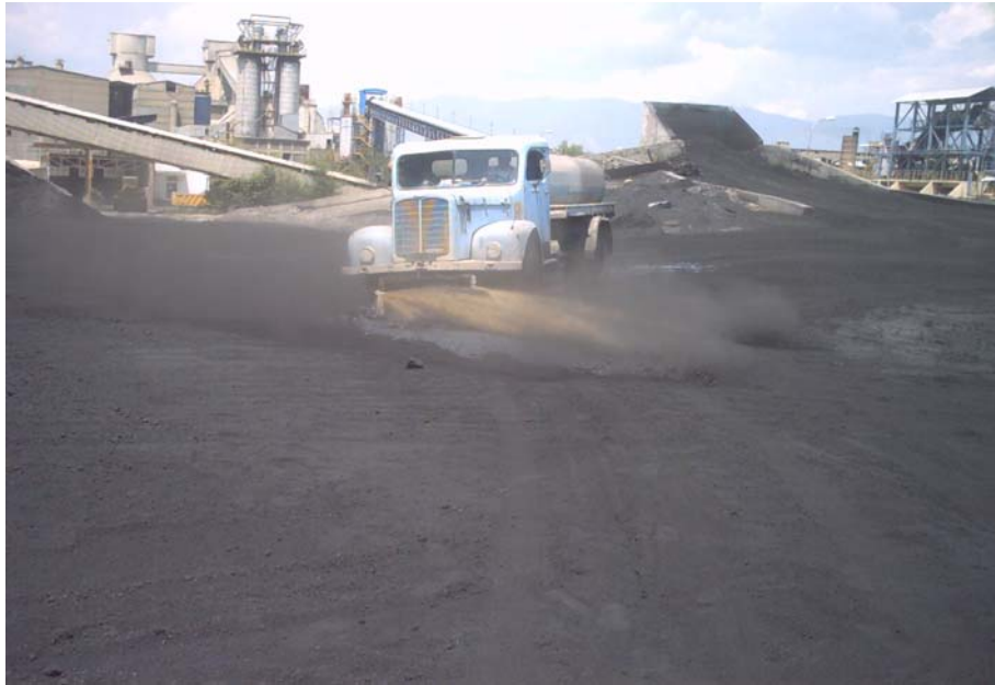
слика 3. Распрскување (апликација) на адитивите на транспортните патишта
